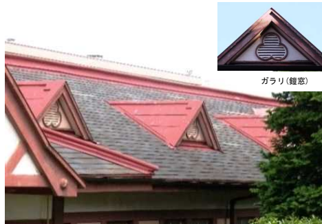
西翼のドーマー窓(屋根窓)
