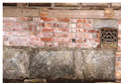
廊下床下の基礎
