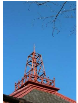
東端部の避雷針・固定鉄骨
