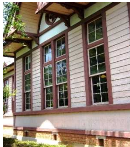
正面東翼の外壁
