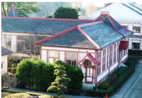
西棟端部の全景
