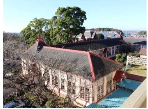
東棟端部の全景
