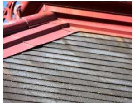
スレート葺き屋根
