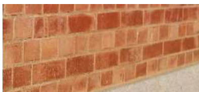
イギリス積み(旧本館基礎の煉瓦積み)
