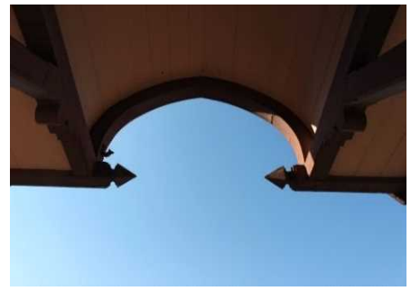
妻小屋根の尖頭飾り
