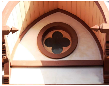
西翼端の切妻破風の庇飾り
