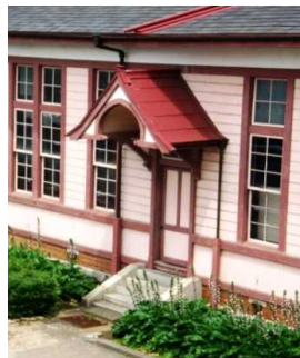
西棟西出入口の妻小屋根
