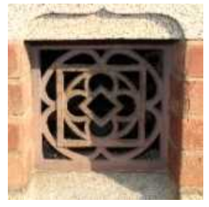
基礎の通気孔飾りの金具
