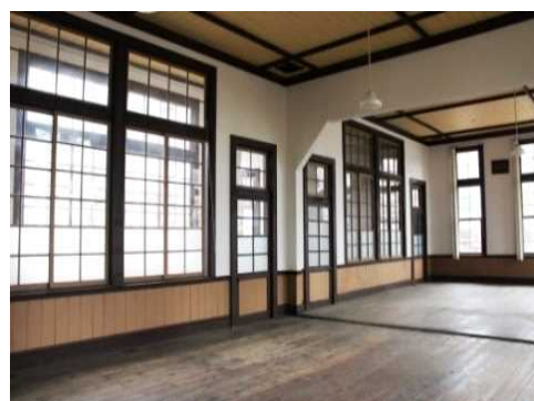
明るく開放的な職員室、隔壁の痕跡
