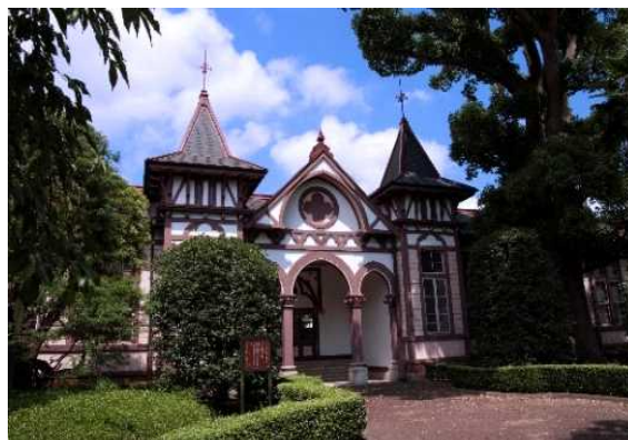
盛夏の旧本館・玄関ポーチ
