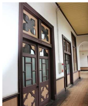
校長室出入口の観音扉
