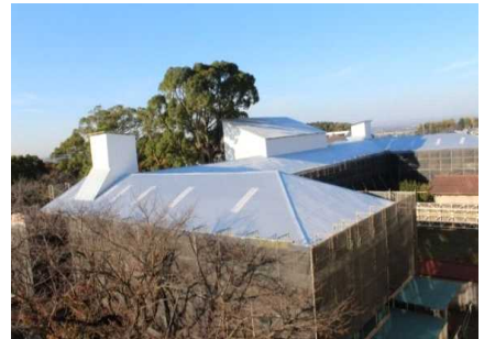
工事用覆いと仮設屋根
