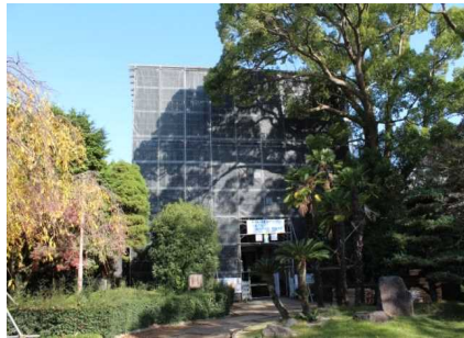
旧本館正面の工事用覆い
