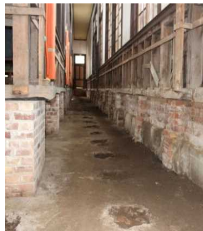
廊下床下の煉瓦積み基礎
