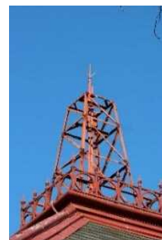
東端部の避雷針・固定鉄骨
