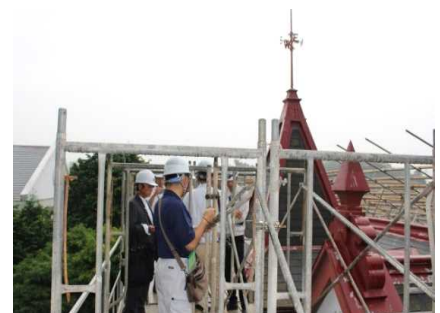
文化庁の改修工事視察
